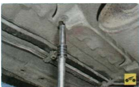
22. Снизу автомобиля отверните четыре гайки крепления термоэкрана дополнительного глушителя...
