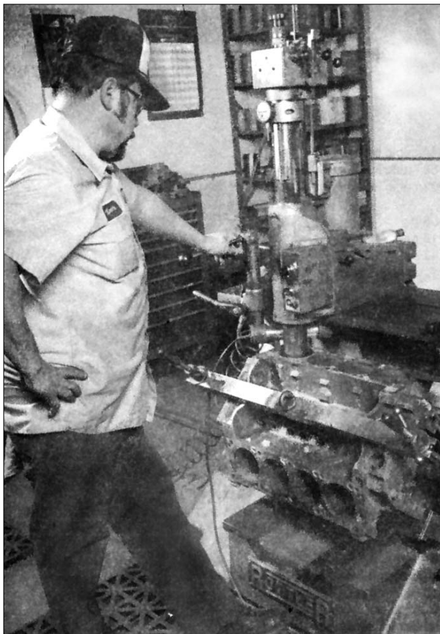
Рис. 1.2. Расточка блока цилиндров – специалист по капитальному ремонту использует специальную установку для восстановления поверхности цилиндров
