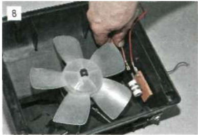
Отсоединяем провод вентилятора от дополнительного резистора...
